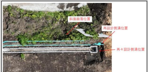
写真右:雨水流出の原因は、側溝を据える場所の斜面が崩れており、流路計算に影響を与えていると仮定した。この場所が軟弱地盤であると想定し、さらに内側に側溝を据えることで対応した。
