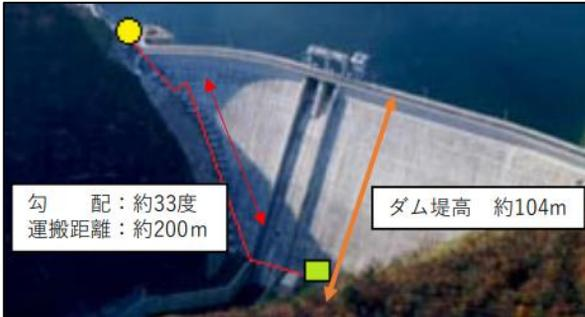
写真左:ダムでの工事は勾配がきつ、人力での運搬距離も長くなる
