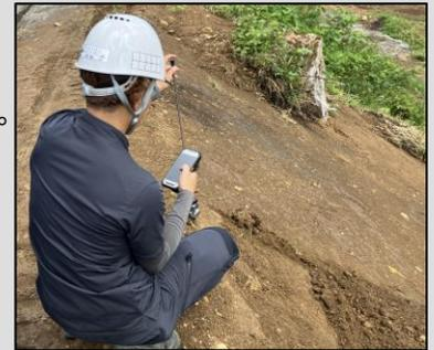
写真下: 設計データと法肩の測量地点を合わせている。
