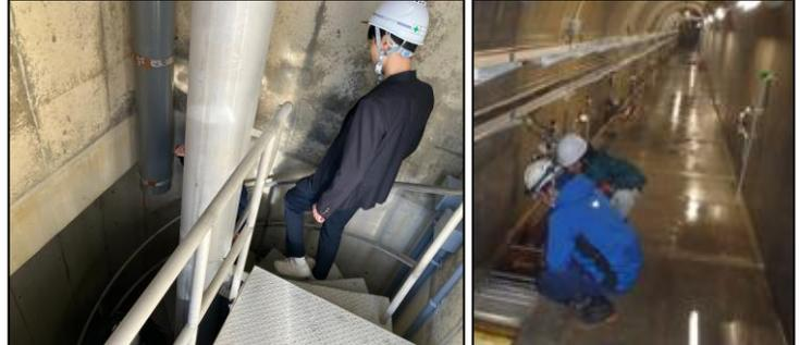
写真右:ダム現場は急こう配や狭い部分が多く、機械を用いた運搬や作業が難しい
