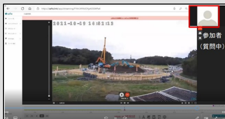
Safieによる現場ライブ中継 （現場全景）
