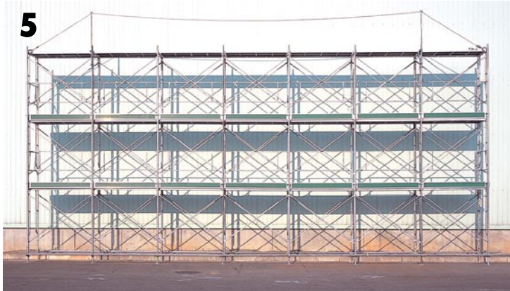
折り畳み二段手摺の設置終了
