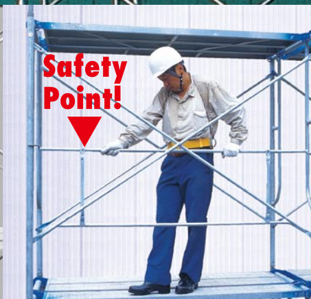
折りたたみ二段手すり施工後
