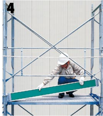
つま先板の取り付け
