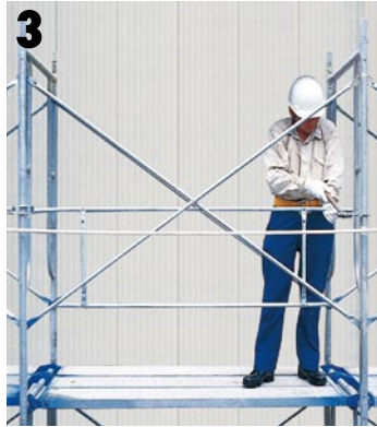
手摺(上線)を建枠にハンマーで固定
